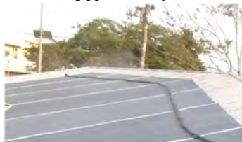
写真5. 簡易ポンプによる散水
