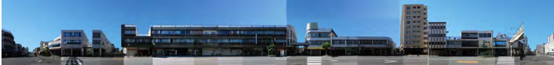
沼津 本通防火建築帯（1954年度 日本建築学会賞（行政）、2018年 DOCOMOMO認定）
