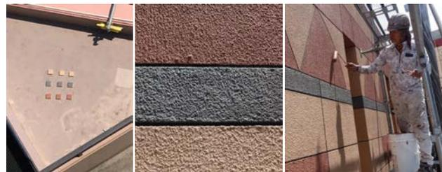
三州瓦微粉末塗料を使った暴露試験と試験施工@三河安城市
