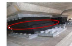
東北地方太平洋沖地震でのゴム支承の破断(利府高架橋)
