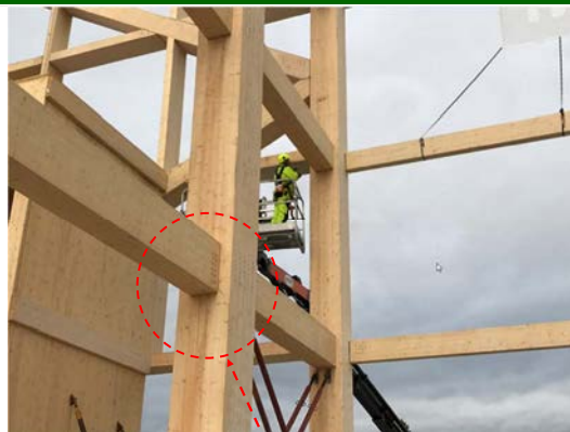
鋼板挿入型接合(部分的)
