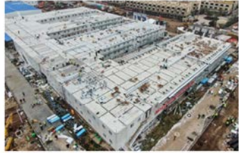
プロジェクト開始から10日で建設された中国・武漢の「火神山医院」。建設現場などで利用される「ユニットハウス」を組み合わせたつくりになっている（写真：新華社/アフロ） （画像のクワックで拡大表示）
