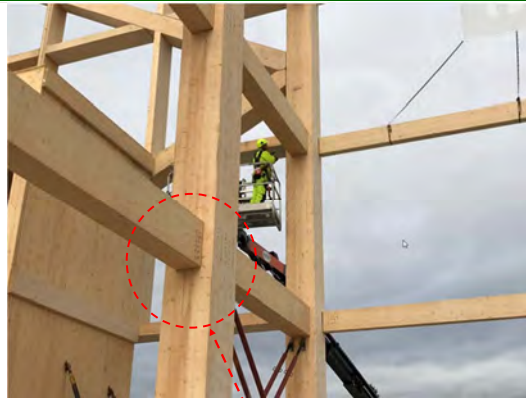
鋼板挿入型接合(部分的)
