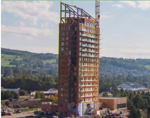
ミョースターネット(現在、世界最高高さ 木造) 18階建て、高さ約85.4m
