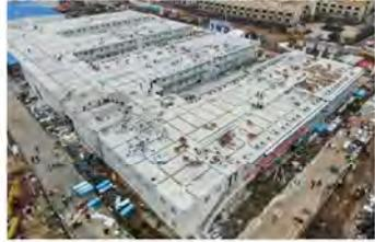
プロジェクト開始から10日で建設された中国一完成した「火神山医院」。建設現場などで撮影された「コンクリートハウス」を積み重ねたつくりになっている。（写真：日経クロステック）
